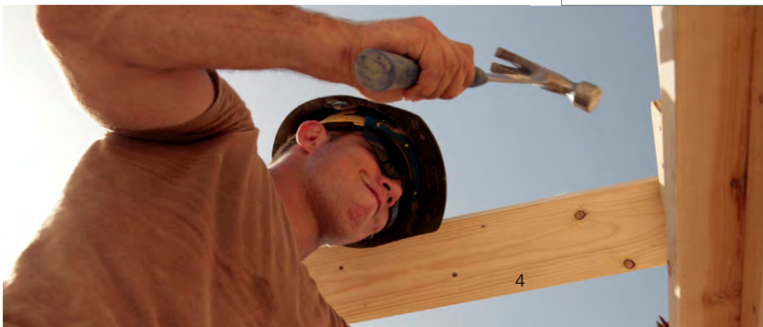
Contreventement diagonal en bois sur les murs d'extrémité. Utilisez au moins un clou de 8d (63 mm) par montant ou plaque d'intersection, et prévoyez des contreventements dans les deux sens sur chaque mur d'extrémité.
