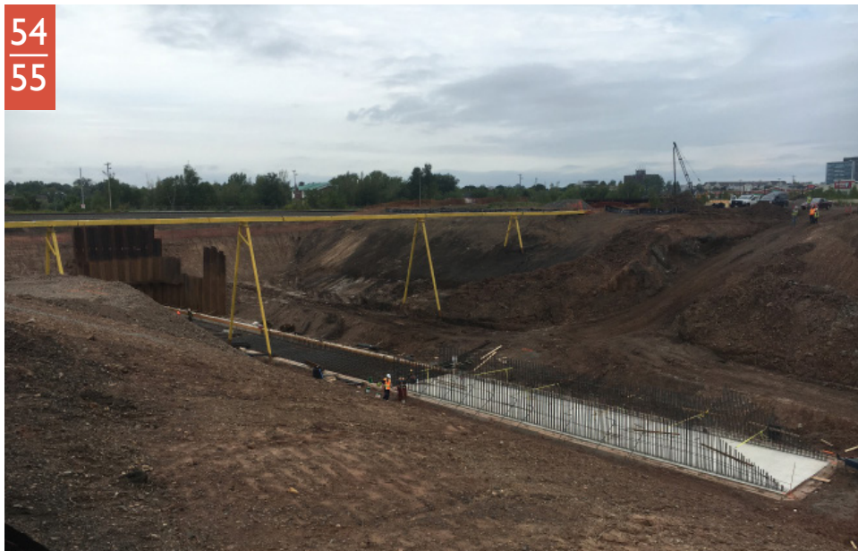
Figure 12 : Construction du nouveau ponceau à Moncton. (Source : Ville de Moncton)
