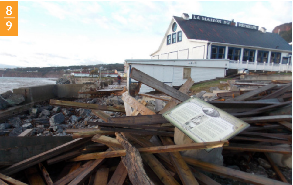
Figure 2 : Dommages causés par une violente tempête en 2016 dans la ville de Percé. (Source : Ville de Percé)
