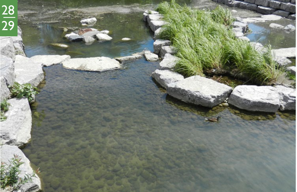
Figure 6 : Le projet d'amélioration du lac du parc Victoria (Victoria Park Lake Improvement) comprend un nouveau bassin de sédiments. Il a été conçu comme un réservoir de stockage initial pour emprisonner les sédiments et les polluants lourds afin que l'eau se décante avant d'atteindre le bassin principal. (Source: IPSC)
