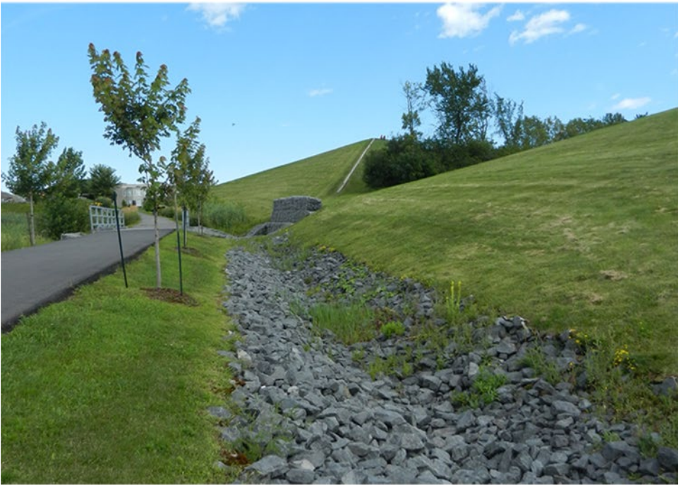
Figures 26 et 27 : Des fossés de drainage ont été aménagés le long des corridors multifonctionnels pour relier les bassins secs et les lacs de rétention. (Source : IPSC)
