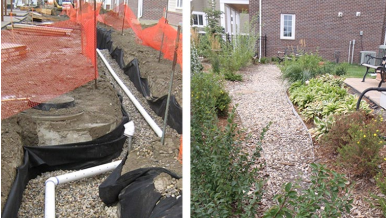
Figure 25 : Les photos ci-dessus montrent une tranchée d'infiltration ajoutée dans le cadre du projet de réaménagement des terrains contaminés de Currie Barracks. Une tranchée d'infiltration est une tranchée excavée remplie de pierre pour créer un étroit réservoir souterrain. Les eaux de ruissellement qui y sont dirigées s'accumulent au fond de la tranchée et finissent par pénétrer dans le sous-sol et dans la nappe phréatique. (Source: Ville de Calgary)
