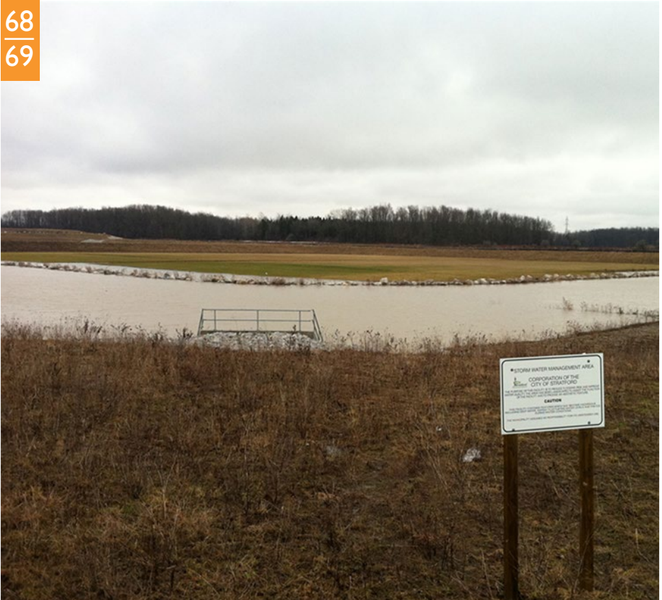
Figure 16 : Bassin de rétention des eaux pluviales construit à Stratford pour contre la surcharge des réseaux d'égouts locaux. (Source: Ville de Stratford)
