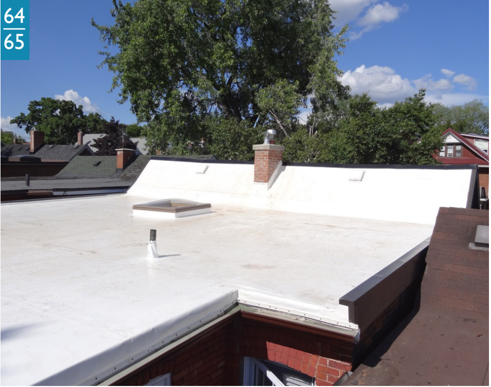
Figure 16: Un des nombreux toits construits dans le cadre du Programme de mesures incitatives pour les toits écologiques à Toronto. (Source: Ville de Toronto)
